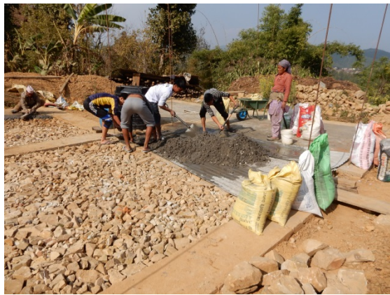
図5 再建住宅の基礎と防湿層の建設
