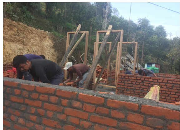
図6 再建住宅の壁面の建設
