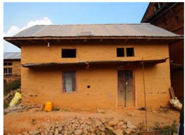
図-10 元の敷地から少し離れた場所で再建された住宅
