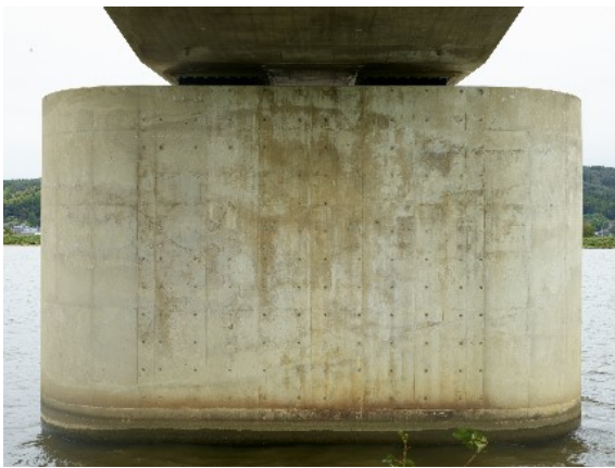
図-3 ひび割れ診断実験対象画像
