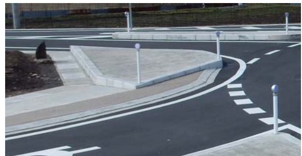
図-20 隅切り部の段差構造
