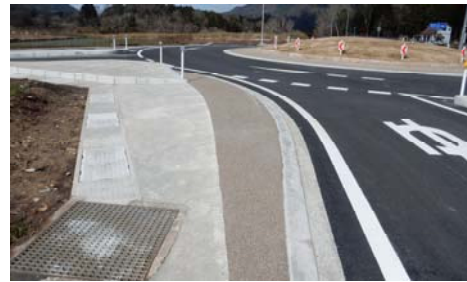
図-18 設計対象車両による必要な幅員の差
