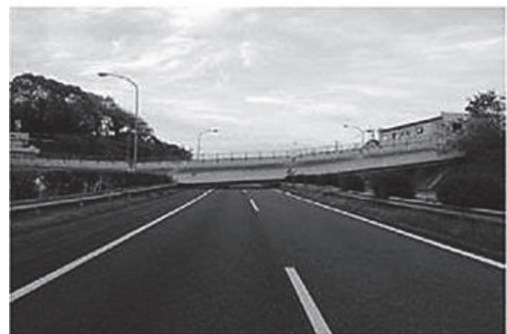
写真-1 熊本地震における跨道橋（府領第一橋）の落橋による九州自動車道の支障（2016年） 2)
