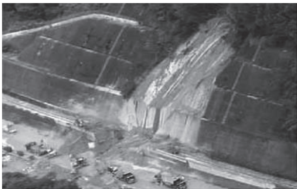
写真4 中国・九州北部豪雨時の土石流の流入による九州自動車道の支障 (2009年) 5)
