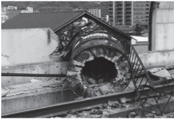
写真2 熊本地震における沿線民間工場の煙突崩落による九州新幹線の線路支障 (2016年) 3)
