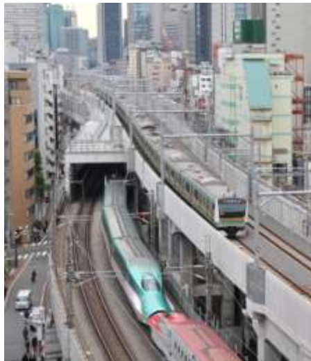
図-5 神田駅付近の状況
