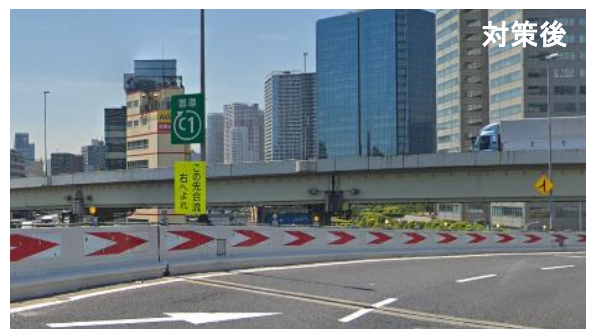
図-6 現地状況 (路面矢印設置後)
