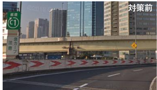
図-5 現地状況 (路面矢印設置前)
