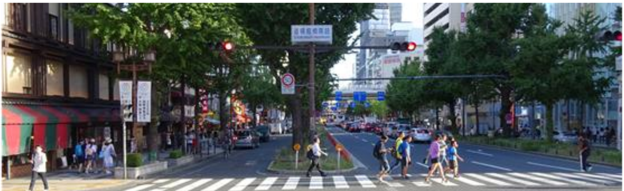
図-10 実験前の道頓堀橋南詰から難波交差点間の状況
