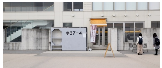
写真-3 アクリル窓付き防潮壁-建物壁面線近接タイプ
