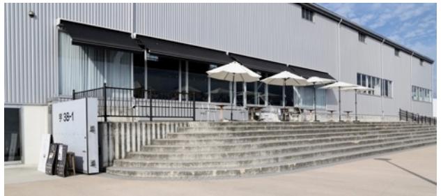
写真-6 倉庫と大階段の見えがかり
