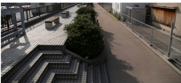
写真-1 防潮壁と大階段付きテラス
