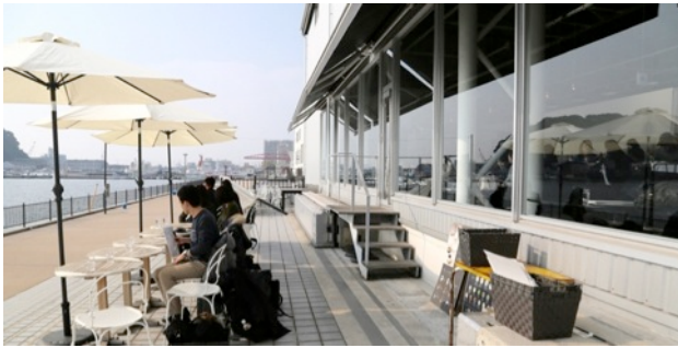
写真-5 防潮壁-建物壁面線密接タイプ
