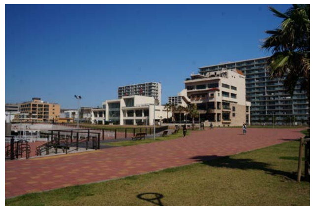
図-16: 整備された緑地空間の状況
