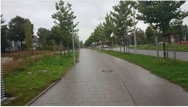
写真-1 都市部でトラフィック機能を確保した道路 (沿道アクセスは主要信号交差点に限定されている)
