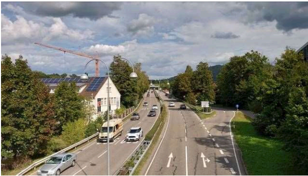
写真-2 郊外部でトラフィック機能を確保した道路 (近くに商業施設があるが、本線から直接アクセスできない)
