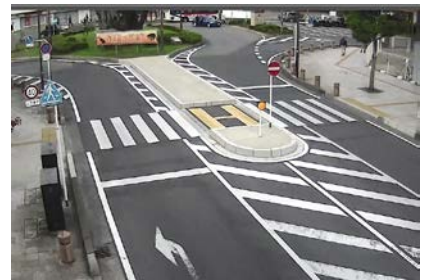
図-3 春日部二段階横断施設
