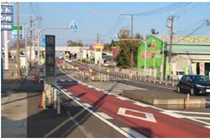
図-1 宮崎二段階横断施設
