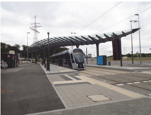
写真-2 LUXEXPO電停の全景
