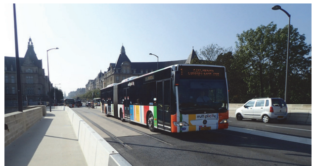
写真-4 バスレーンとして暫定利用されている軌道敷
