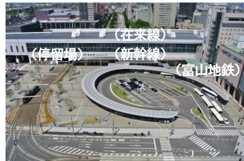
図-3 富山駅南口広場(全景)
