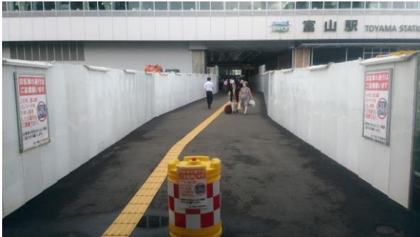
図-28 南北自由通路(2019年4月一部暫定供用)
