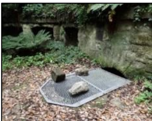
写真11 金網で塞いだ観音崎第二の縦穴
