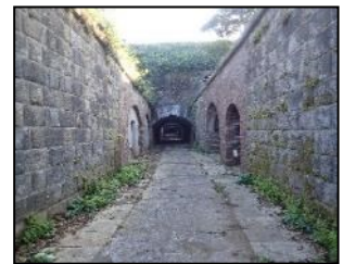
写真-2 石積みとレンガ積みが混在する千代ヶ崎砲台跡
