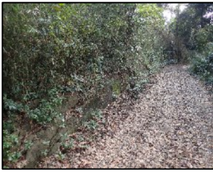
写真5 未舗装となっている金谷へのアクセス路
