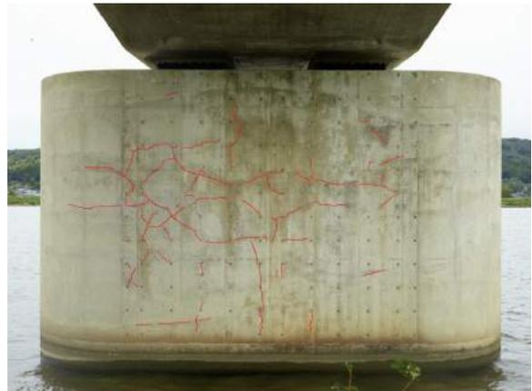
図-4 ひび割れ診断結果の一例
