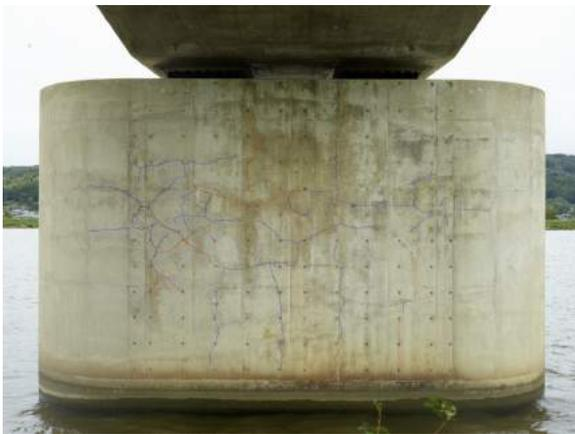
図-7 近接目視点検結果から作成した正解データ
