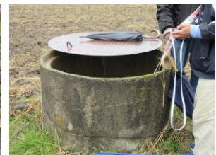
写真-6 取水口近くの堅穴
