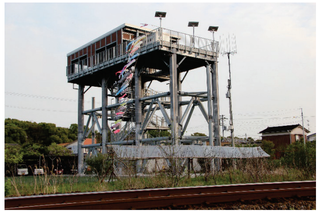
写真-3 津波避難タワー（黒潮町町地区）
