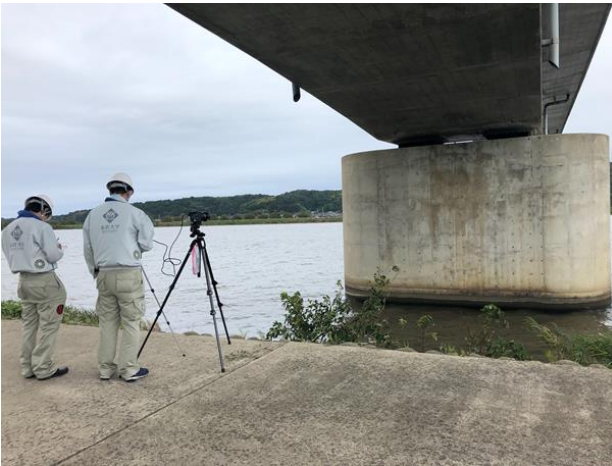
図-1 超解像度カメラを用いたRC橋脚の撮影様子
