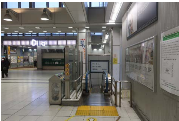
図-1 観測したエスカレーター
