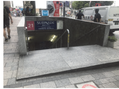
図-9 開放型の例（新宿歌舞伎町地下街出入口）
