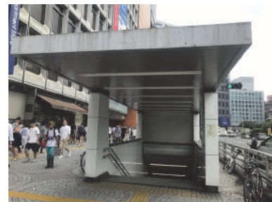
図-10 囲壁型の例（新宿西口地下街出入口）
