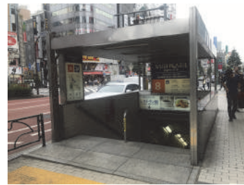
図-6 被覆型の例 (新宿歌舞伎町地下街出入口)
