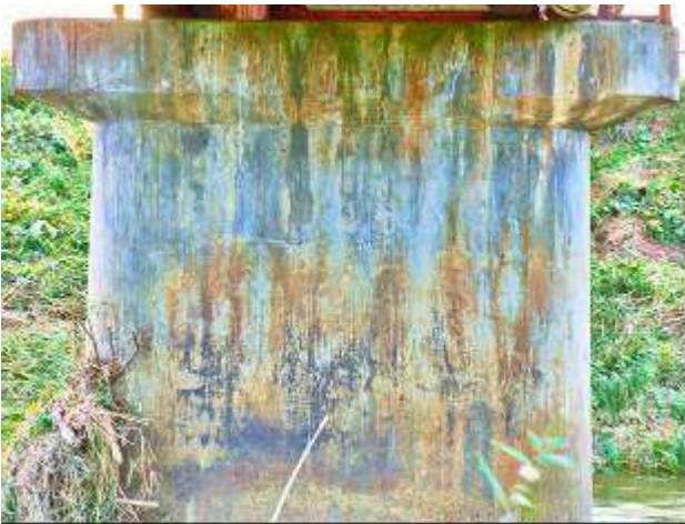
図-3 本研究で対象とするコンクリート橋脚
