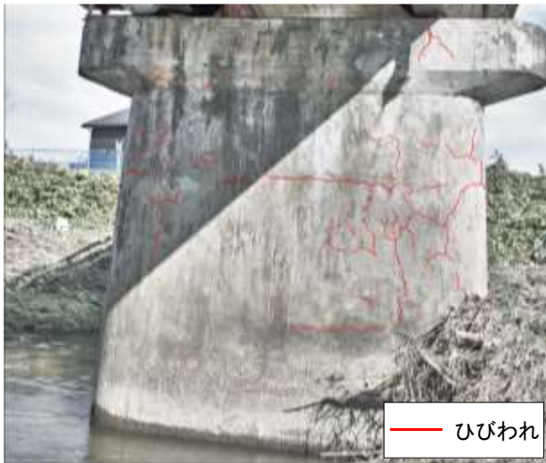
図-10 診断実験によるひびわれ診断結果
