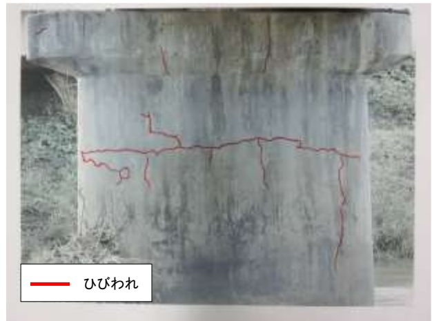
図-7 橋梁点検の経験者（A氏）による診断結果
