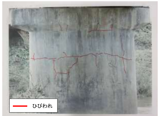
図-8 橋梁点検の経験者（B氏）による診断結果
