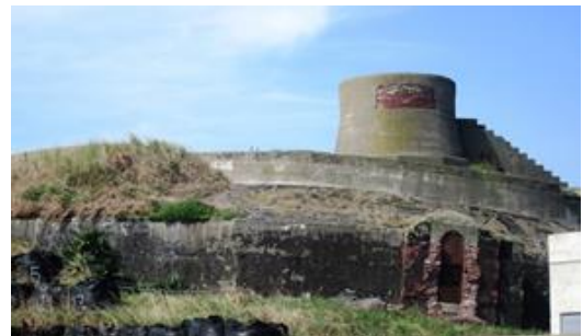
写真-1 第二海堡の砲台跡（27 糶加農砲と観測所）
