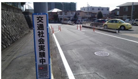
図-14 狭さくの設置状況（陽東地区）
