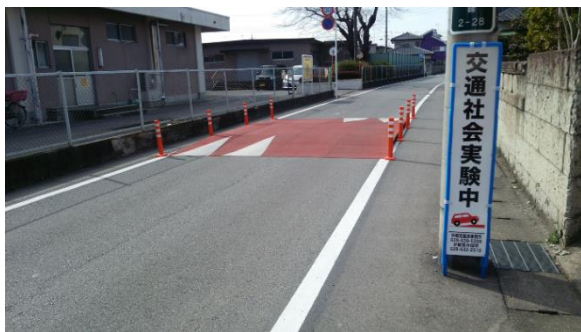
図-13 ハンプの設置状況（峰地区）
