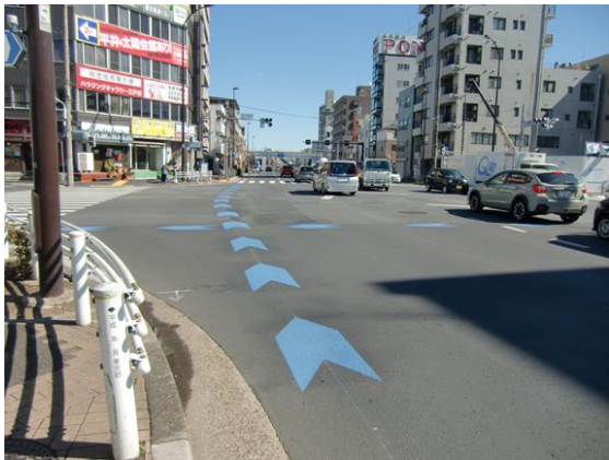
写真-2 自転車ナビライン設置状況
