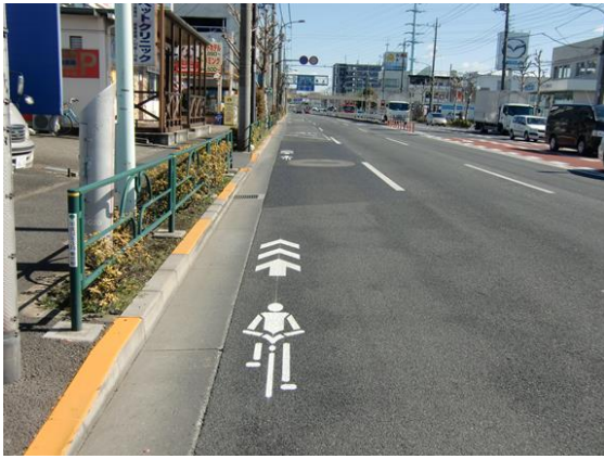
写真-1 自転車ナビマーク設置状況
