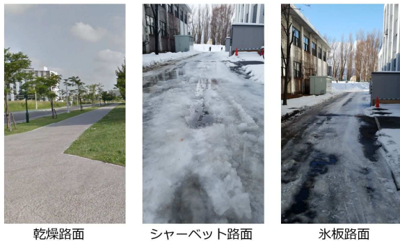
図-5 実験(1)実施区間の路面雪氷状態
