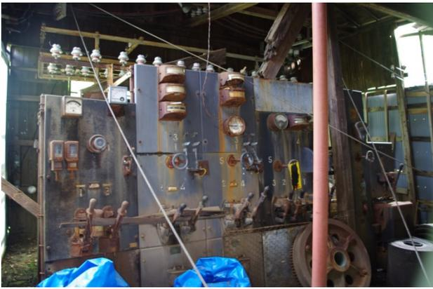
写真9 圧気機への電力操作盤
