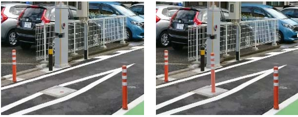
図-2 ライジングボラード(左:稼働前 右:稼働中)
