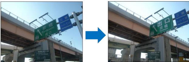
図-5 対策前後の京橋出口分岐案内標識
