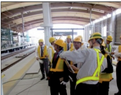
写真4 研修風景（鉄道高架化工事視察時）
