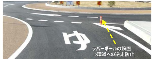
図-13 流入部での環道への逆走進入の対策
