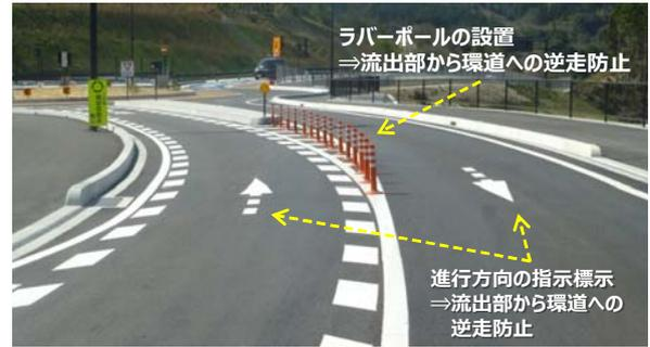
図-12 流出入部の逆走防止と線形誘導の対策
