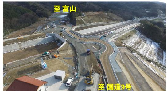
(c) H29.12 終日片側通行規制による路盤打替への施工
