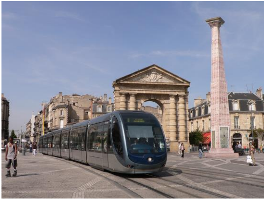
図1 APSを採用したボルドーのLRT
