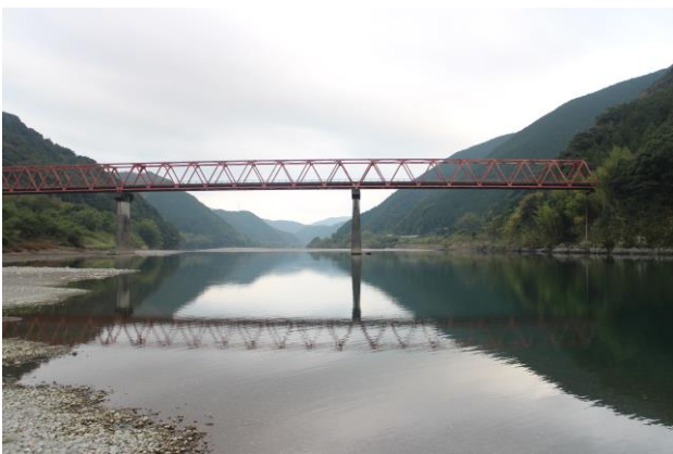
写真-5 トラス橋
