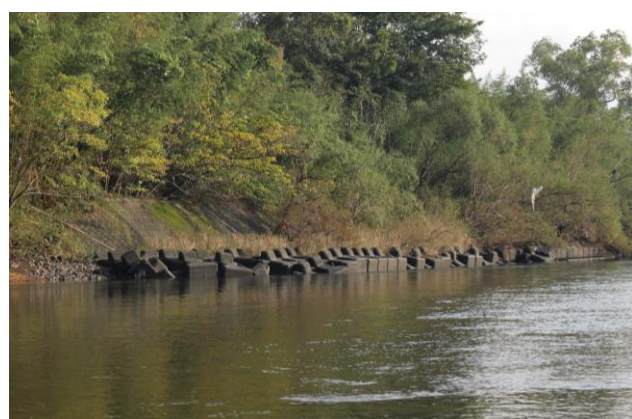
写真-2 消波ブロック
