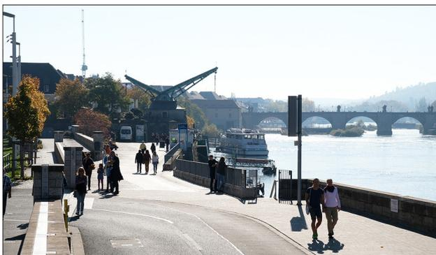
図-5 旧クレーン北側エリア (写真左側が50年確率の堤防壁、右側は10年確率程度の洪水で浸水する)
