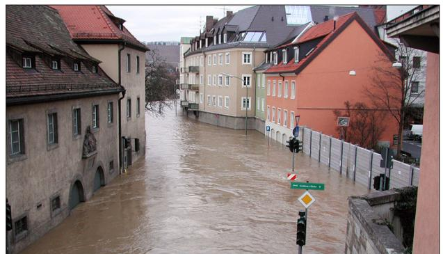
図-6 旧メイン橋下流側の街路に設置された可動式堤防 (写真左側にメイン川本流、街路が氾濫流路になっている)
