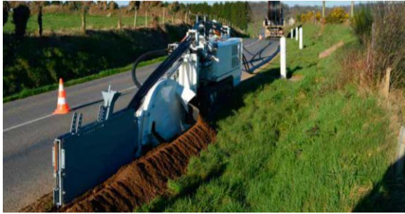
写真3 欧米諸国の農村自然域で採用されているトレンチャーによる掘削と埋設の同時施工 (写真：Rivard 社提供)
