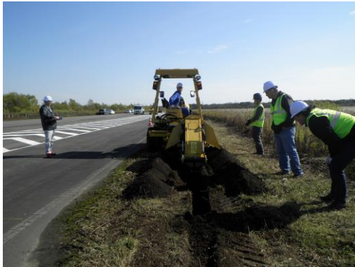
写真4 寒地土木研究所におけるトレンチャー掘削試験
