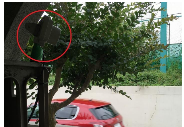
図-4 WCN路側観測器の設置状況(下流地点)
