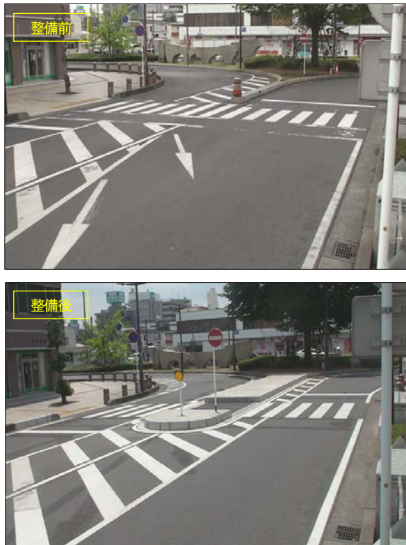
図-2 現地状況写真
