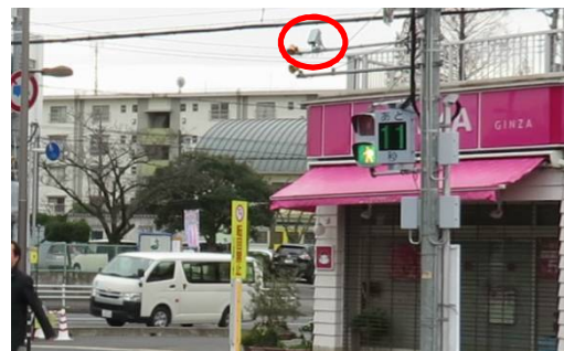
図-2 装置の設置状況（赤丸は感知センサ）
