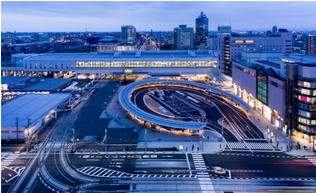
写真－4 北陸新幹線富山駅遠景
