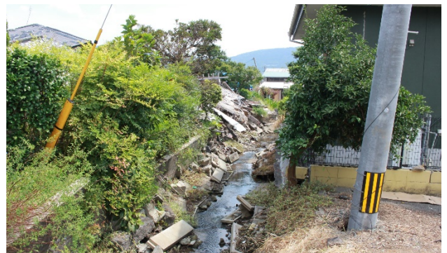
図-5 水路破損の様子
