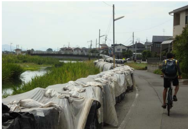
図-2 堤防沈下に対する土嚢対策(秋津川)
