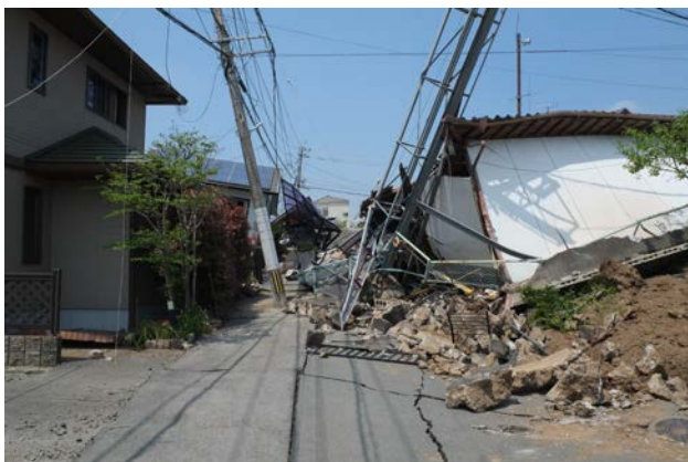
図-1 倒壊家屋によって通行止めとなった狭隘道路
