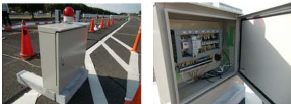
図4 制御盤ボックス
