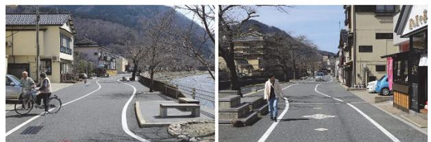
写真3 スラロームの導入に併せて一方通行を指定
