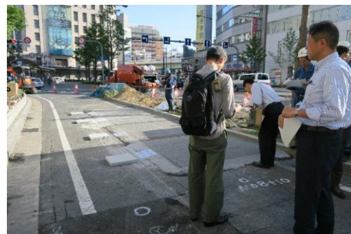
写真-4 半たわみ性舗装の試験舗装の風景
