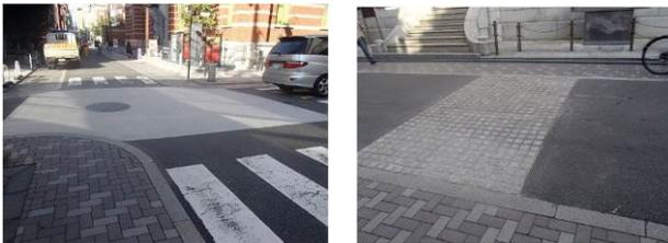
図-17 薄層カラー舗装及び小舗石舗装
