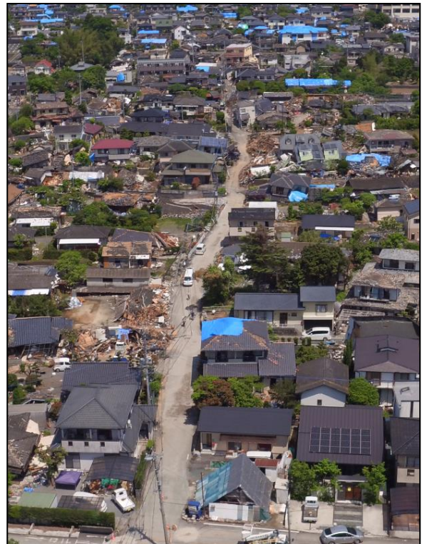
図-1 建物被害データを取得した熊本県益城町宮園地区 (UAVからの映像)
