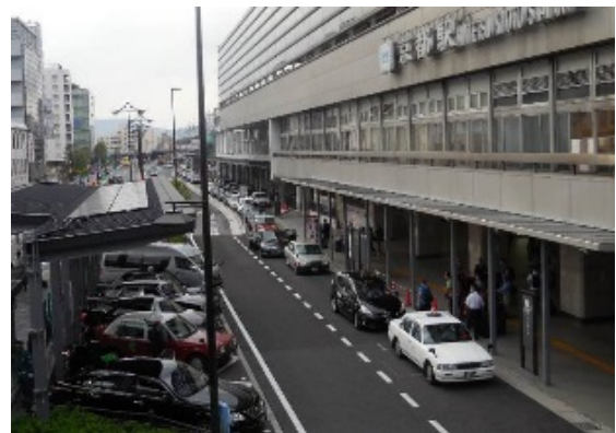
写真-2 整備後のタクシーのりば
