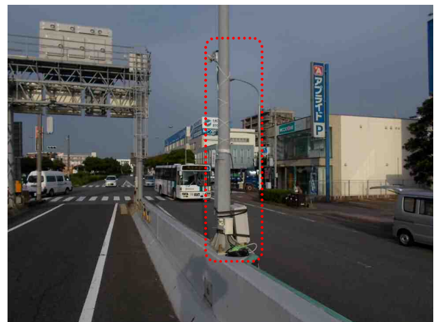
図-6 設置事例（空港通入口）
