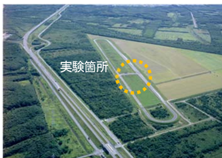
写真-1 苫小牧寒地試験道路
