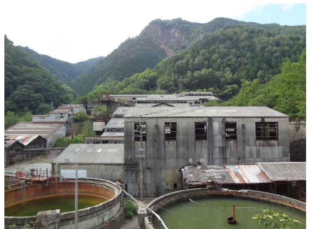
図-1 現在の通洞選鉱所の様子
