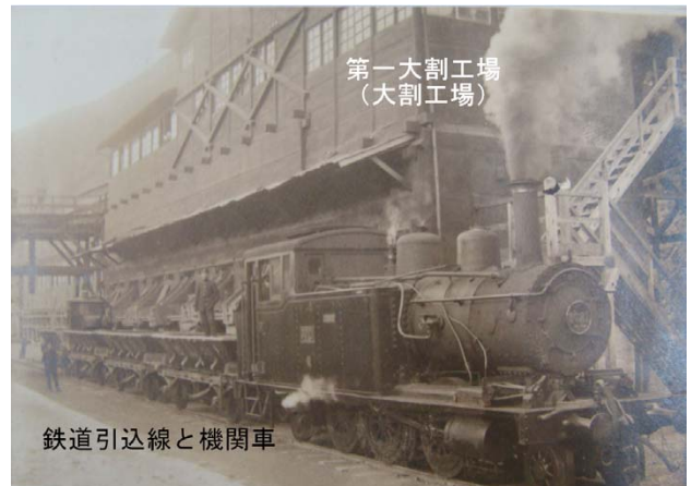
図-17 大割工場とその下段の鉄道引込線と機関車 42)
