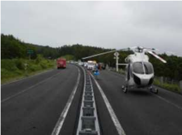
写真-2 道路本線への救急医療用ヘリコプターの緊急着陸
