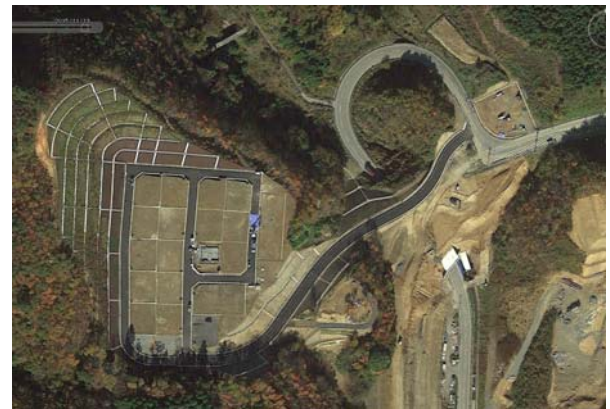
図-4.3 現況写真 (2015.11.13 google earthより)
